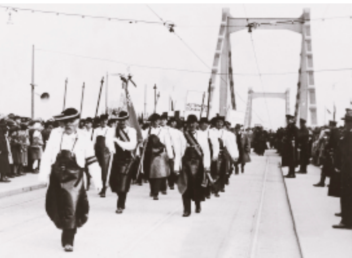
(Abb. 3): Die Gruppe der Donawitzer Arbeiter beim Festzug über die Brücke (ÖNB/Bildarchiv)
